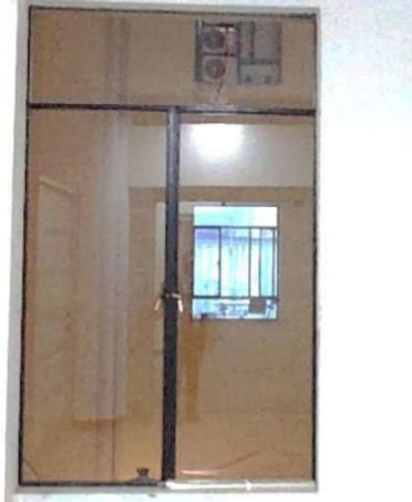
Ilustración 9: Colocación de ventana con marco
